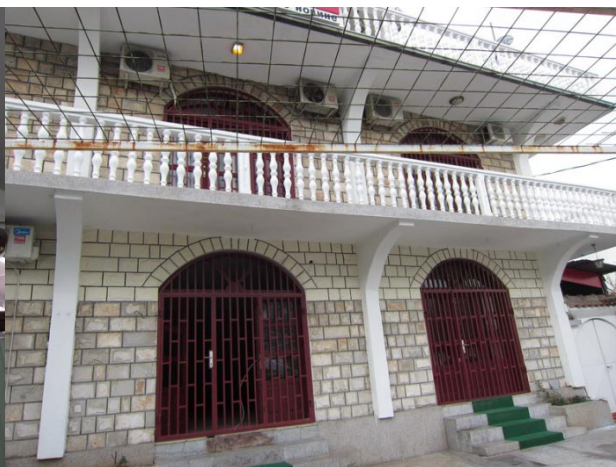
Spoljašnje jedinice klima uređaj
