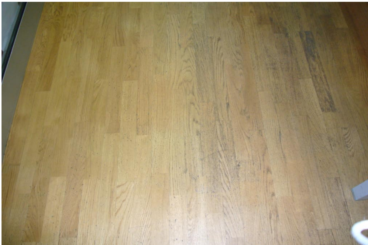
Pod u ulaznom dijelu-parket
