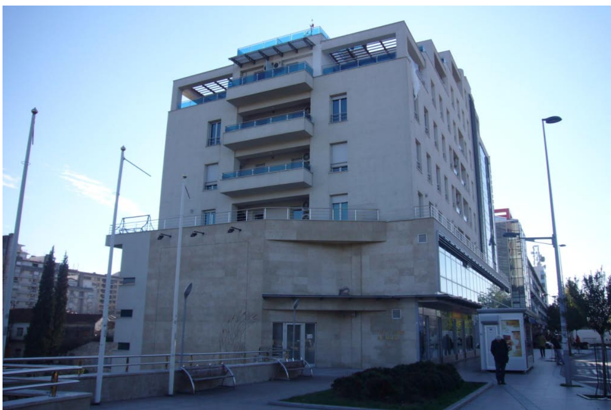
Dio sjeverne fasade
