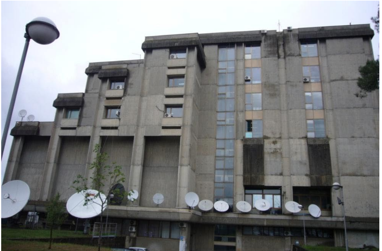
Južna fasada RTCG
