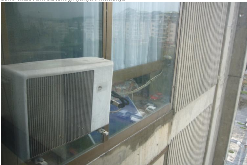
Spoljašnja jedinica klima uređaja okačena na prozor
