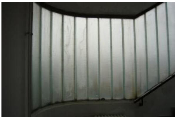
Prozori na stepenišnom prostoru-profilit staklo
